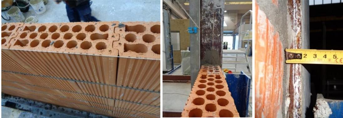
**Figura 4.** Encaje vertical mediante el machihembrado de las piezas cerámicas (izq.), premarco de madera de 20 cm de espesor (cen.) y colocación de la fábrica a 1,5 cm del borde en espera del guarnecido de yeso (der.).
