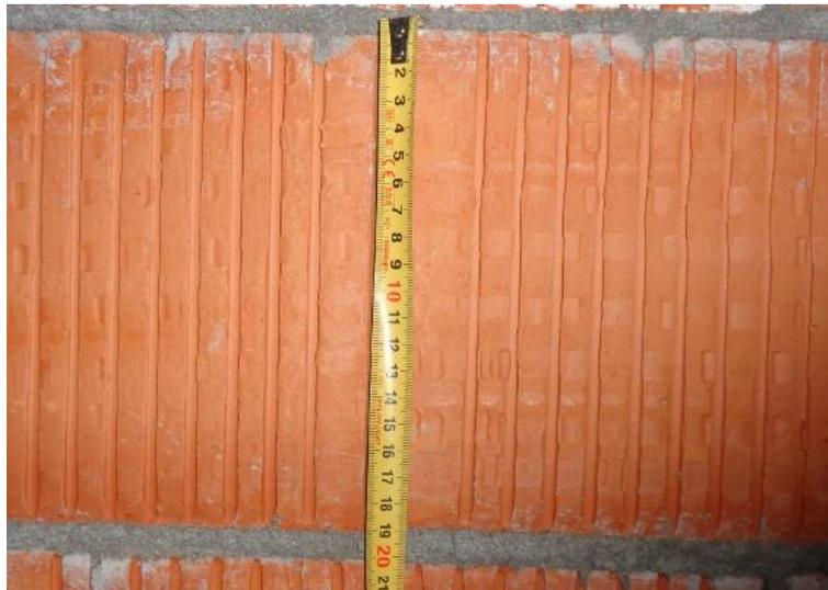
**Figura 5.** Altura de tendel horizontal de 1 cm.
