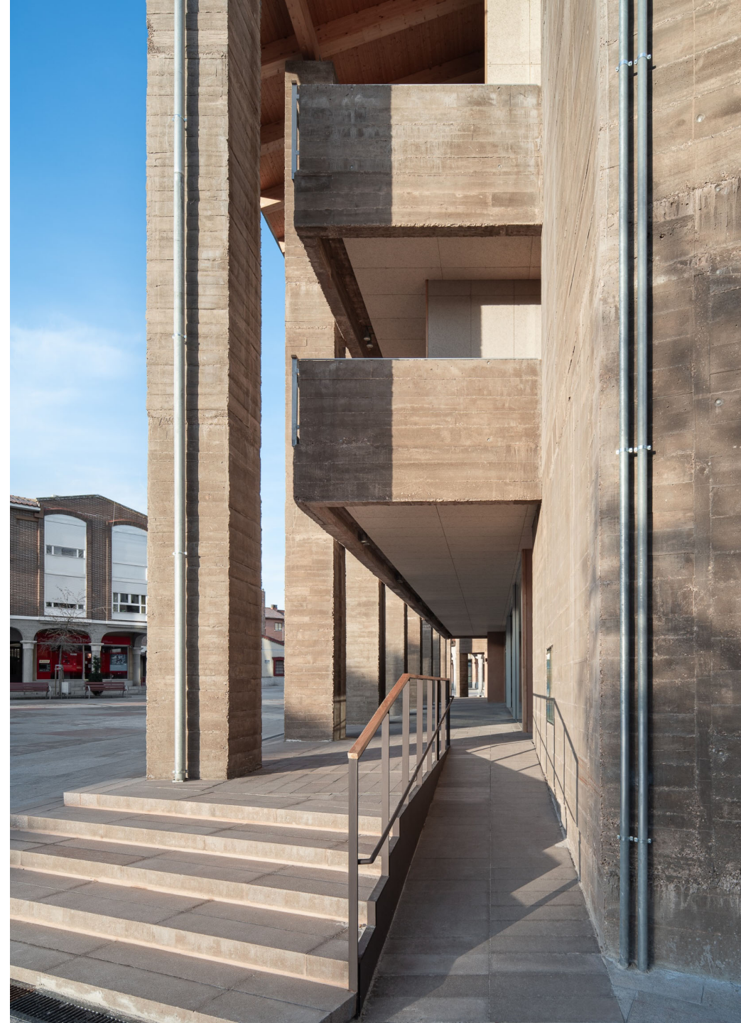
Losas Campo Suit 60x20x8 cm, lisas, color Tostado Peldaños formados con bordillos Campo Urbis 100x20x10 cm monocapa, lisas, color Tostado
