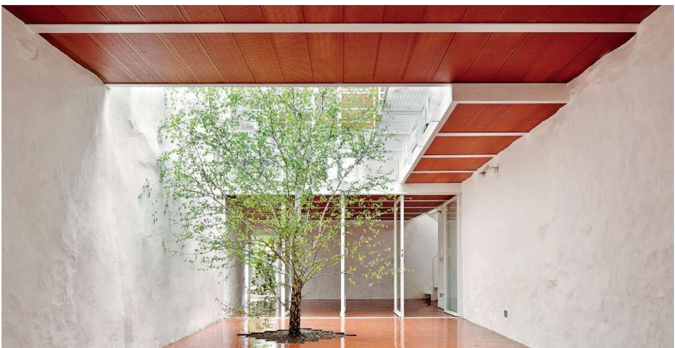
Figura 3. Instalación de tablero sobre vigueta metálica
